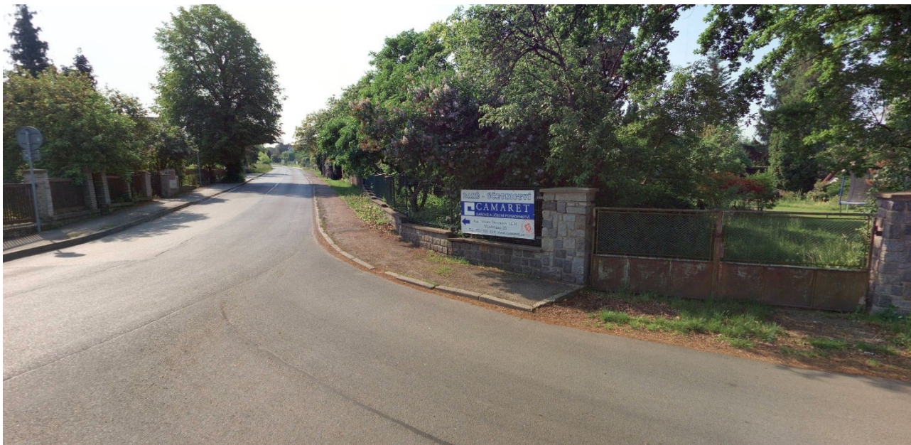
Foto 1 – pohled na stávající chodník a jeho ukončení v ZÚ dle staničení v této dokumentaci (patrná absence prvků pro OSSPO, nevyhovující výškové oddělení, zhoršený stav původního asfaltového krytu chodníku)
